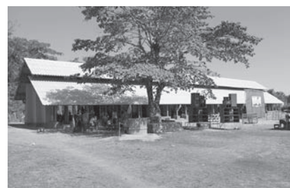
竣工した小学校
