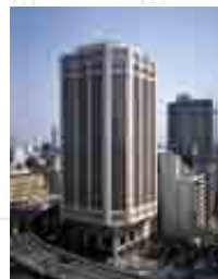
▲大同生命大阪本社ビル
