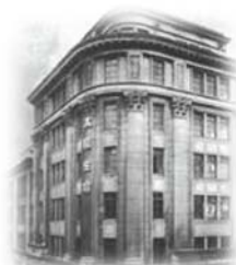
太陽生命旧本社（東京都） 1930年竣工
