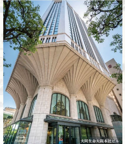
大同生命大阪本社ビル
