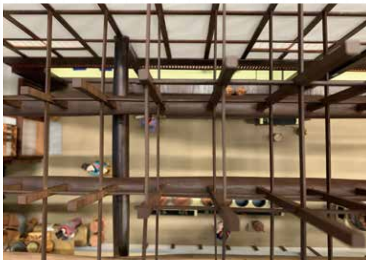
2022.06.08 台所の梁組から土間を見下ろす（模型の屋根がかかると見えなくなる）
